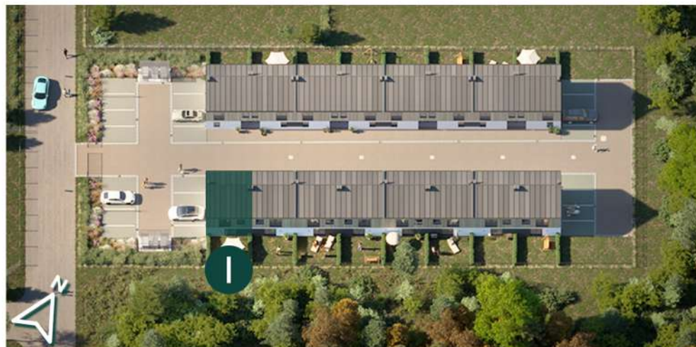
Widok budynków z lotu ptaka
