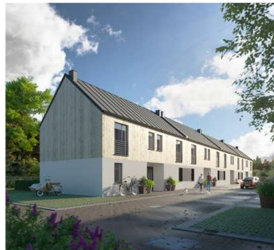
Widok od strony ulicy
