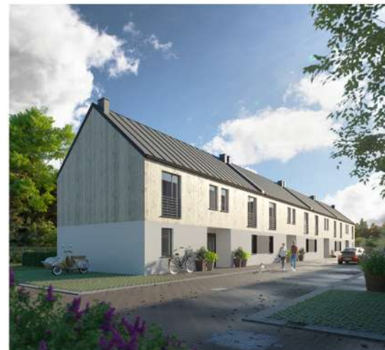
Widok od strony ulicy
